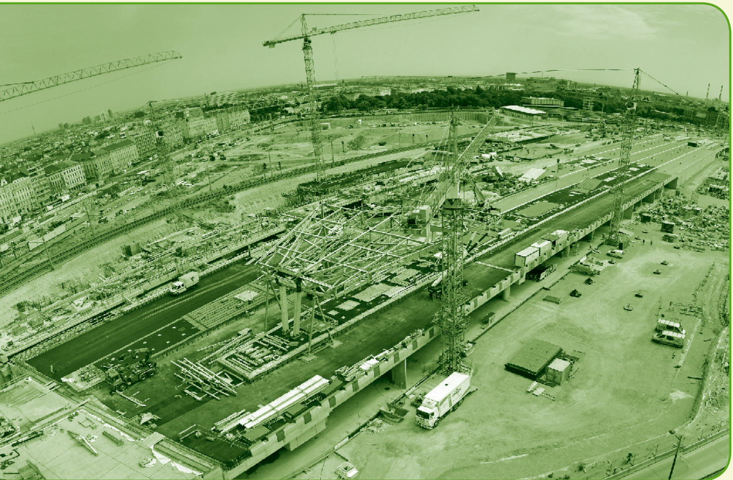
LuTax: Auch innerhalb der Dienststelle Steuern eine Grossbaustelle
