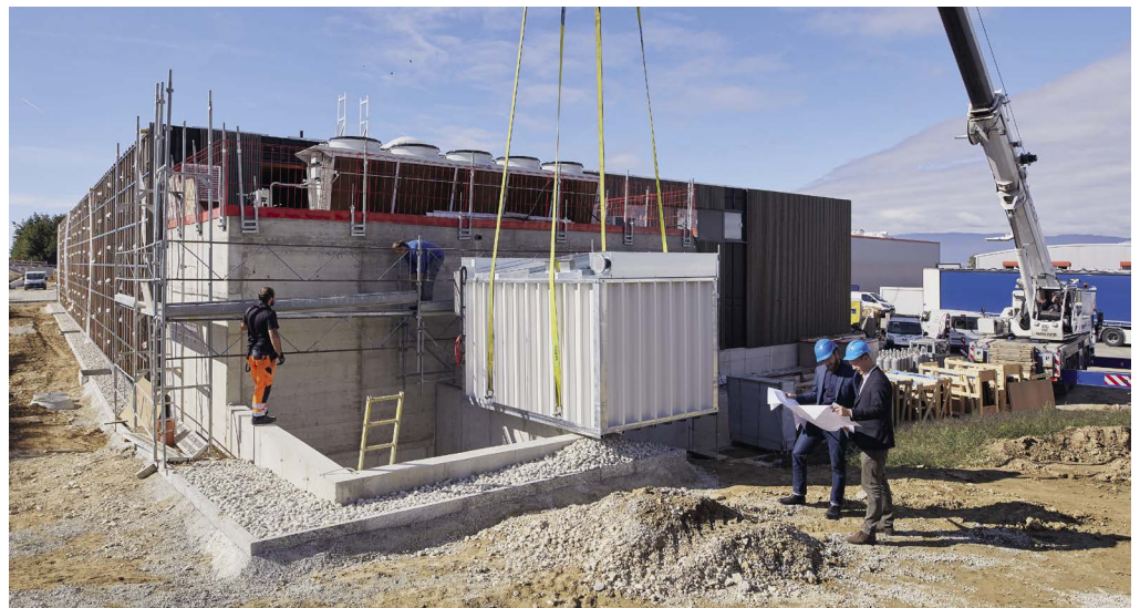
Installation des Eisspeichers (grauer Container)
