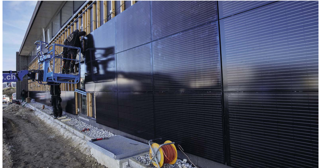
Installation der PV Anlage an der Fassade
